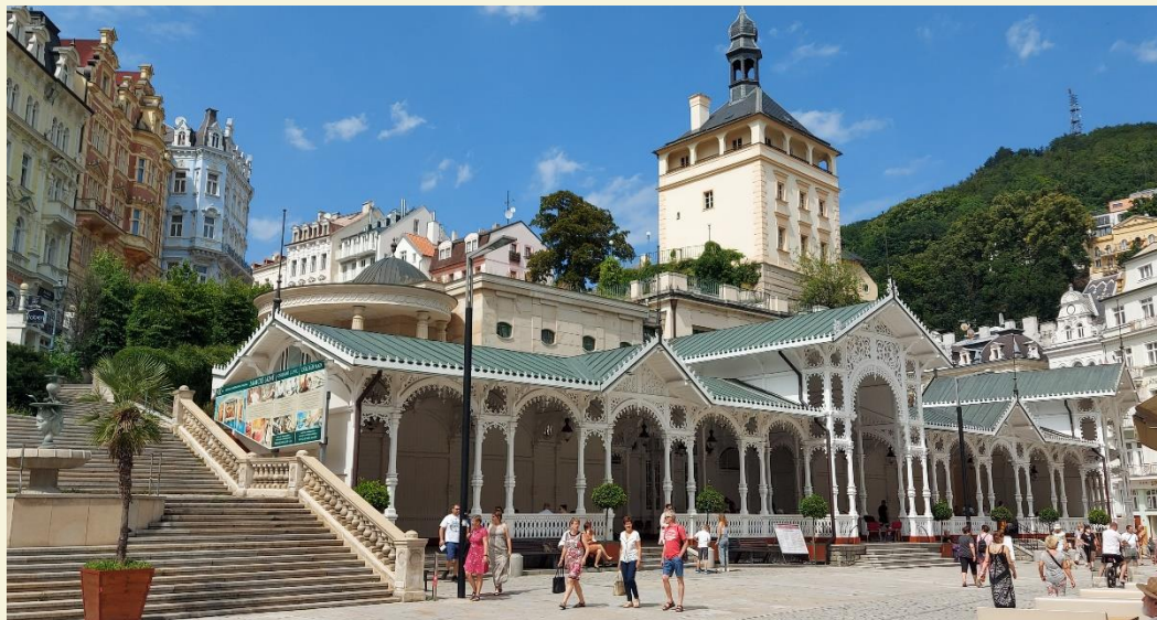
A Piackolonnád a sétálóutcában
